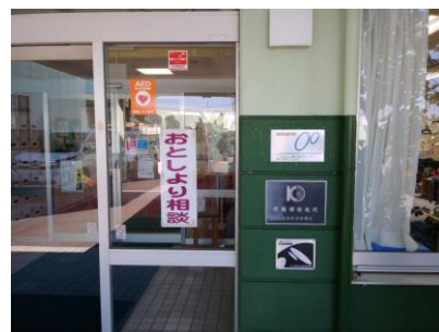
建物入口付近
